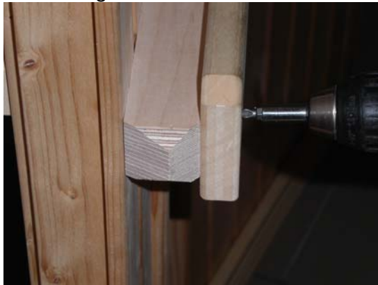
Abb. 5 Äußerer Türgriff bündig mit Türaußenkante
