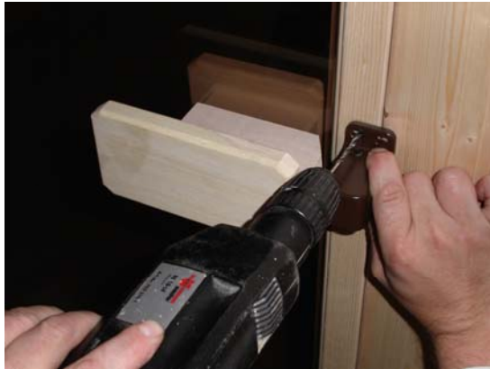
Abb. 4 Rolle unter Spannung leicht anbohren
