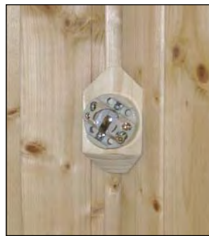
Bild 2 Unterteil der Fassung mit Eckhalter
