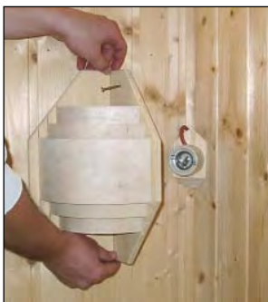
Bild 4 Den Lampenschirm auf- setzen.
