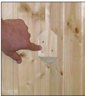
Bild 1 Eckhalter einpassen
